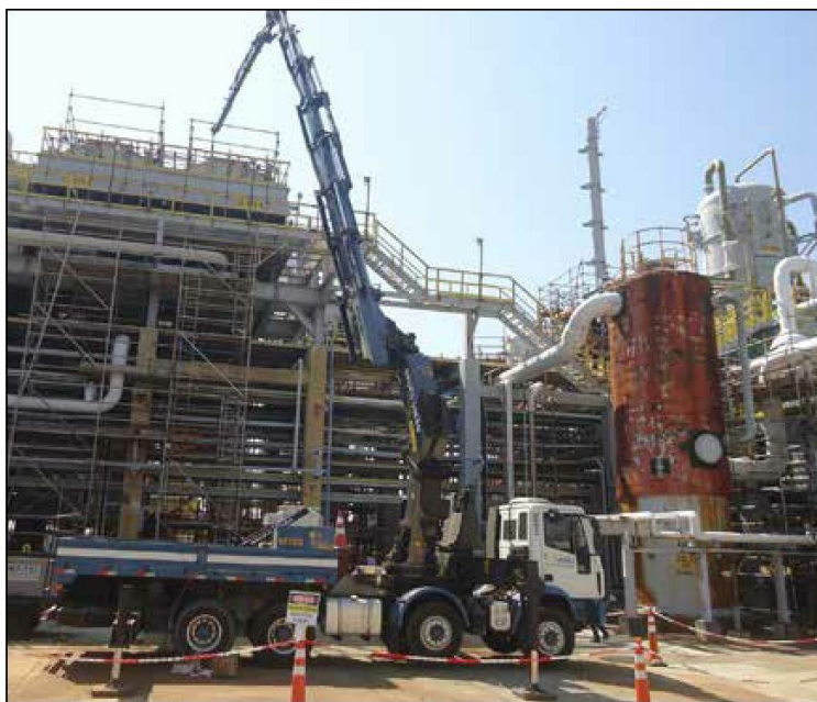
Intervenções exigem equipamentos específicos
