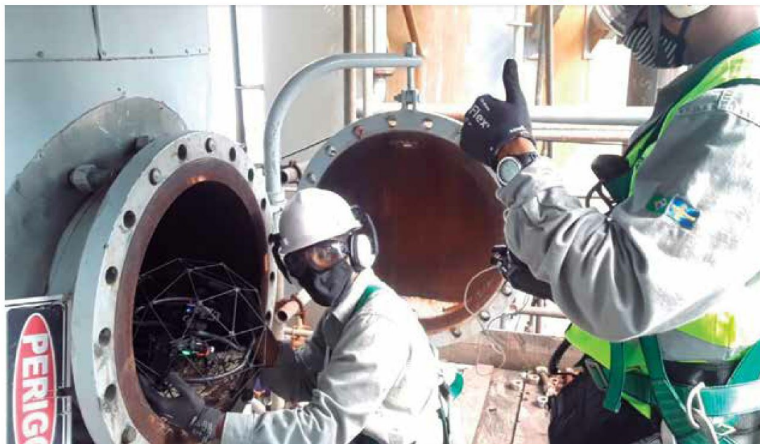
Drone Elios inspeciona parte interna de tanques e chaminés
